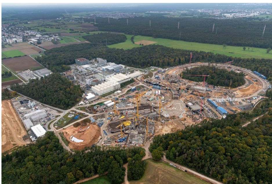
图 1.7 正在建设中的 FAIR。SIS100 的隧道已经完成并已被覆盖。图片来自 [58]
