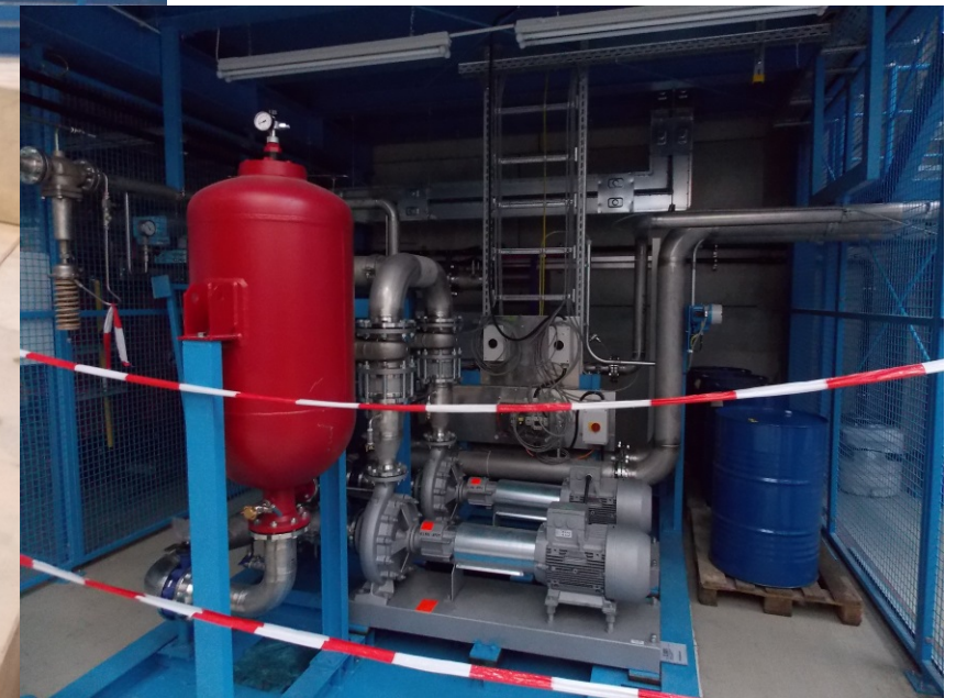
Ölkühlsystem für alle 3 Units (unterste Ebene der Plattform)
