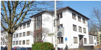
Demolition Alte Pharmazie
